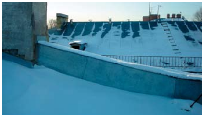
Рисунок 6. Вытяжные отверстия (вид со стороны крыши)
